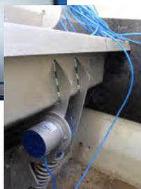
Seuil flexible FluidFlap® limitant le niveau de déversement dans les Bassins d'Orages Équipé d'un inclinomètre. Mesure de niveau amont et calculateur hydraulique. Sur mesure.
