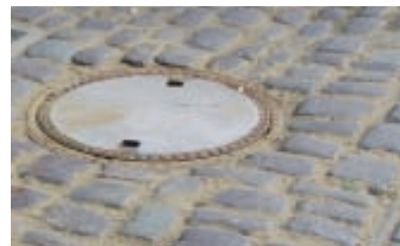
Les deux photos en haut: La couverture des regards peut être de type charge piéton (à gauche) ou circulaire (à droite).
