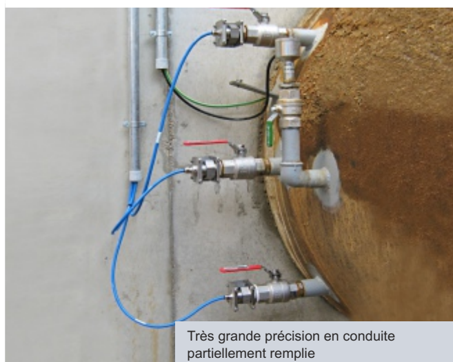
L'alternative au DEM Installation sans démontage du DEM
