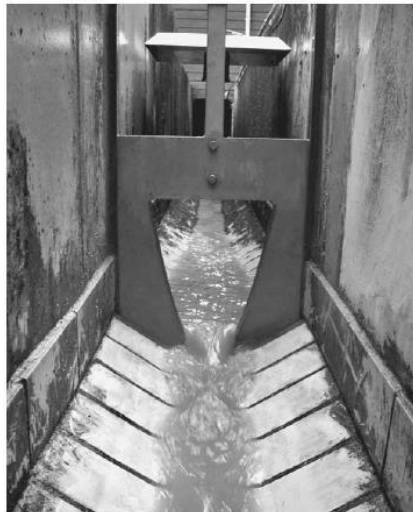
Image 2 : Diaphragme à profil parabolique DN200, équipé après coup, en entrée de station. La sonde ultrasonique pour la mesure du niveau d'eau est fixée sur le diaphragme et protégée par un capot.
