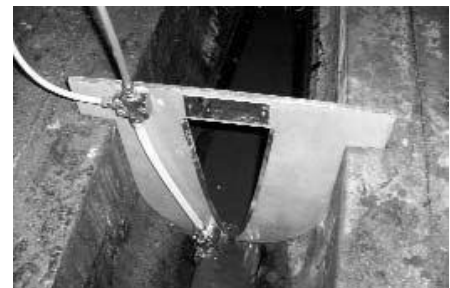
Image 6 : Exemple d'installation d'un diaphragme à profil parabolique UFT-FluidVenturi avec mesure de contre-pression dans le système bulle à bulle.
